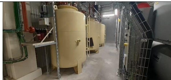
Tanques de los grupos electrógenos
